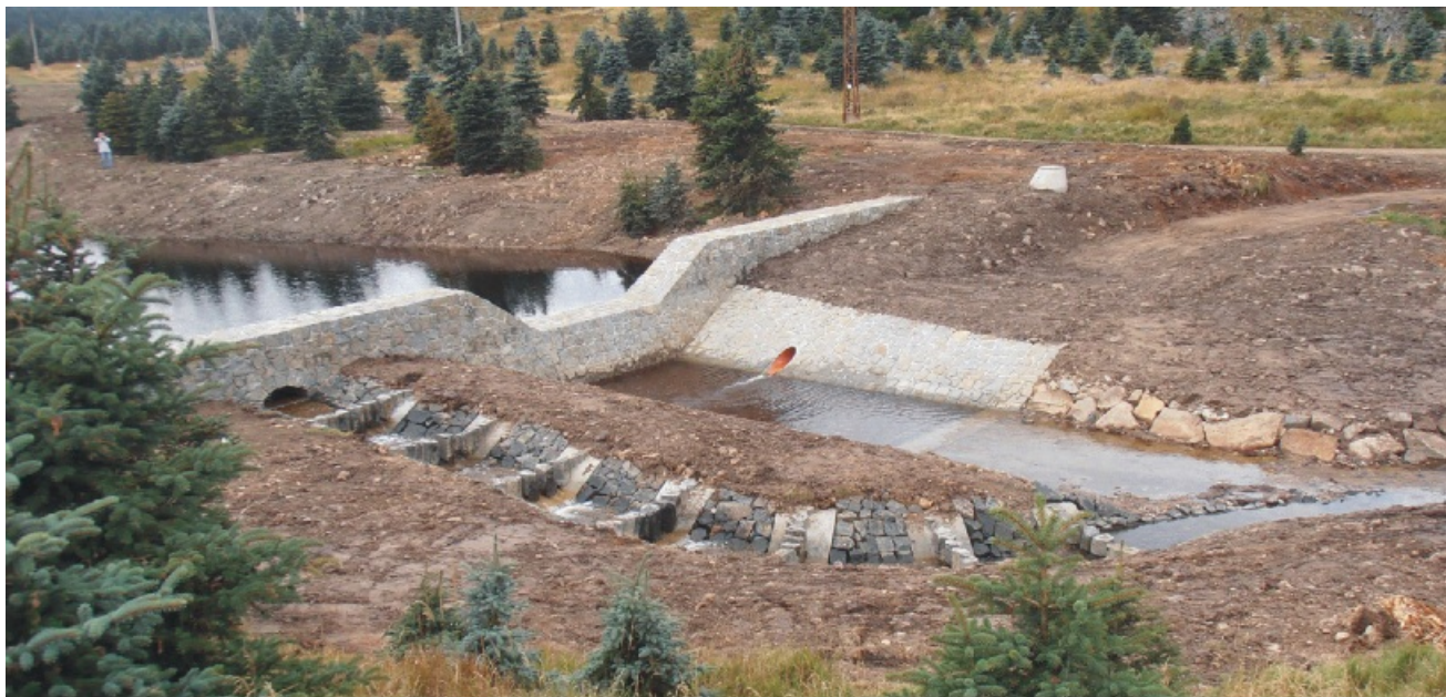
Obr. 7: Rybí přechod na retenční přehrážce Rašeliník na shodně pojmenovaném VT - investorem stavby LČR, s.p. STOPO
