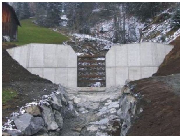
Foto 1: Železobetonová otevřená retenční přehrážka s ocelovými příčníky Săgetobel-Rongtobel [2] Foto: BMLFUW/Zitt
