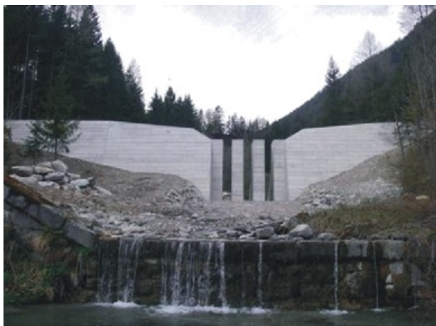
Foto 3: Železobetonová otevřená štěrbinová retenční přehrážka Rückenbach [4]
