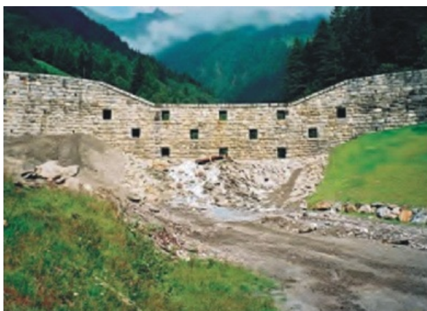
Foto 5: Retenční přehrážka Bretterwandbach (vystavěno r. 1950) [5]
