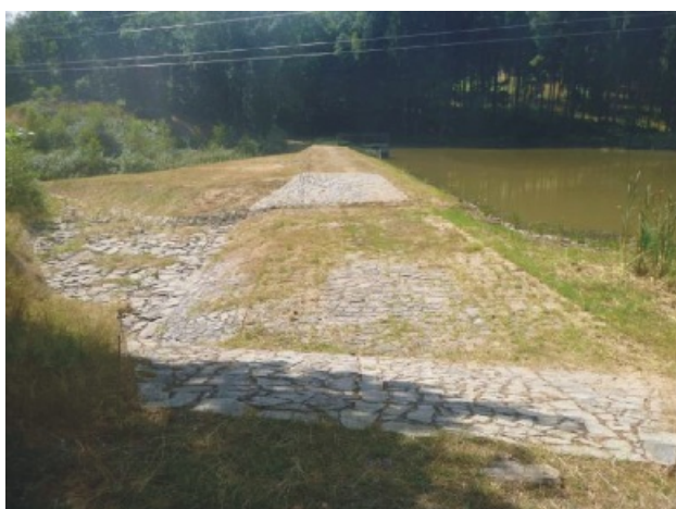
Obr. 1 Retenční nádrž Mydná
