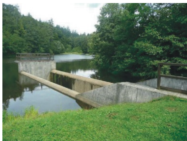
Obr. 2 Retenční nádrž Hamr
