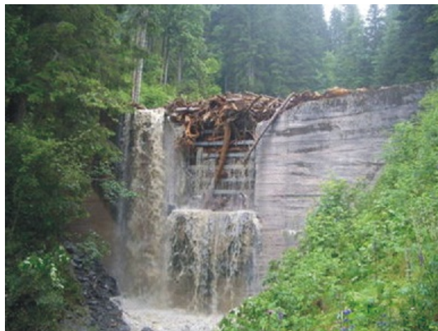
Foto 2: Železobetonová otevřená retenční přehrážka s ocelovými příčníky Pinzgau během povodně [3] Foto: LFUW/die.wildbach/Neumayr
