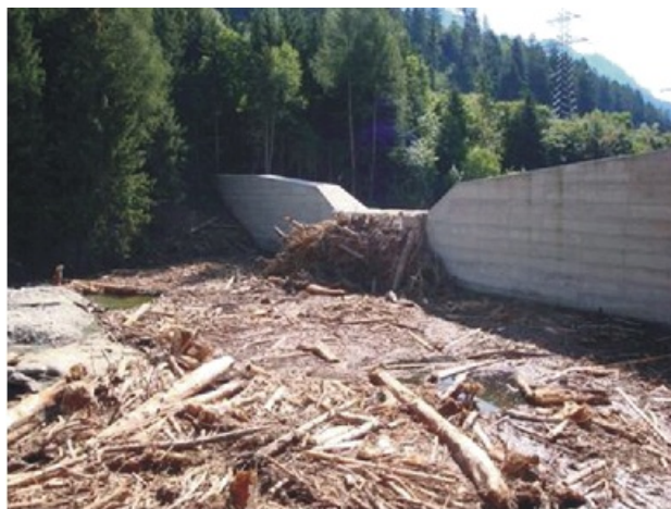
Foto 4: Přehrážka Rückenbach, plávi zachycené v retenčním prostoru po povodňové vlně v červenci 2009 [4] Foto: die.wildbach
