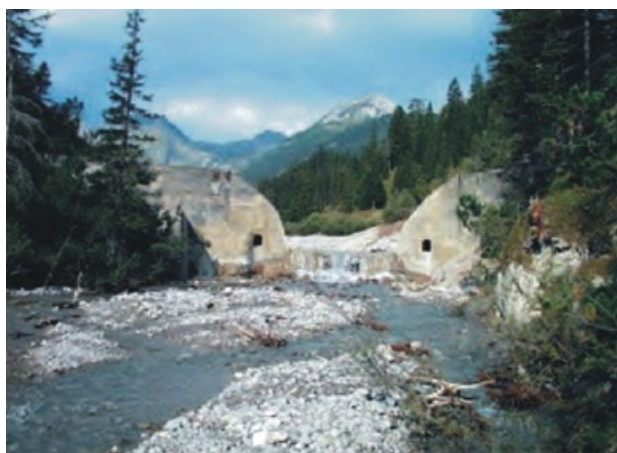
Foto 6: Retenční přehrážka Schwarzwasserbach [5]
