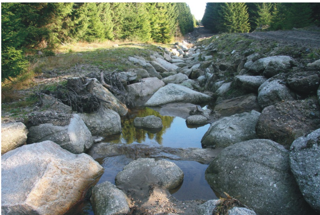
Obr. 4: Úprava horské bystřiny do balvanitého skluzu za použití místního materiálu - Černý potok, pramenná oblast Jizerské hory
