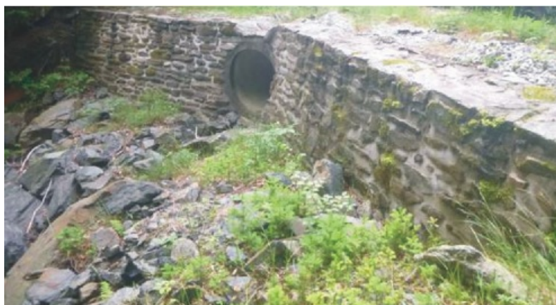
Obr. 7 Strž Příloh - propustek
